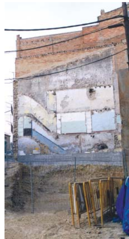
► EDIFICI ENDERROCAT, A PROP DEL PORTAL NOU
