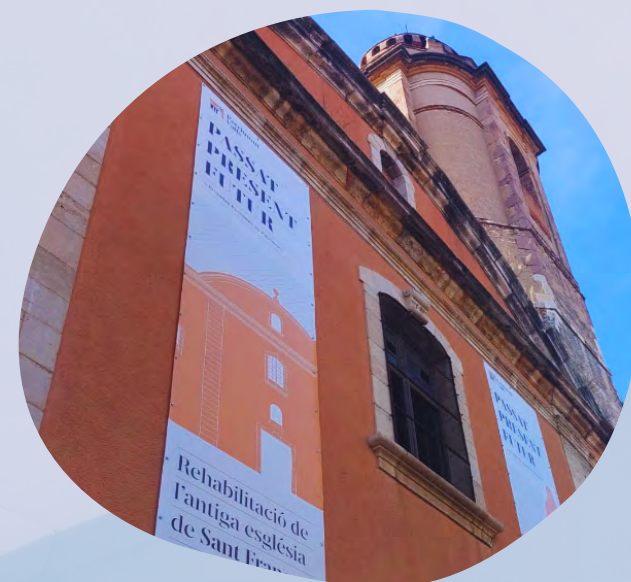
Sant Francesc Rehabilitació de l'antiga església com espai cultural 206.000 €
